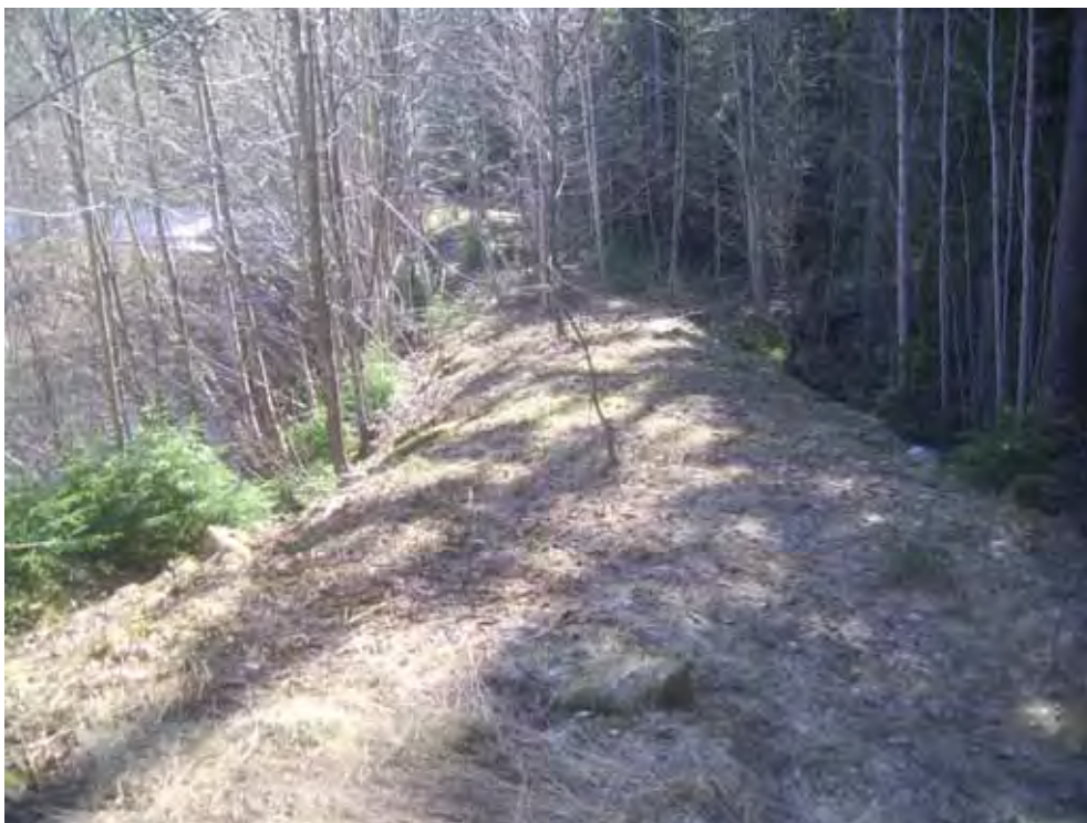
Figur 88. Anlagd dammvall till f.d. viltvatten i Långsjöbäcken.
