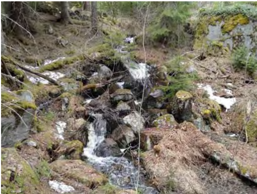
Figur 127. Dammrest i bäcken från Yttertjärnen som måste åtgärdas om fisk skall ta sig upp
