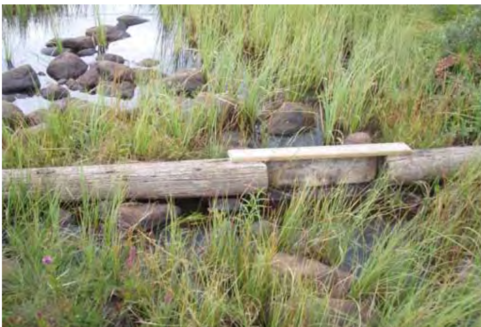
Figur 7. Vandringshinder i form av ett galler applicerat på en tvärgående stock i utloppet på Norra Fågelharsviken.
