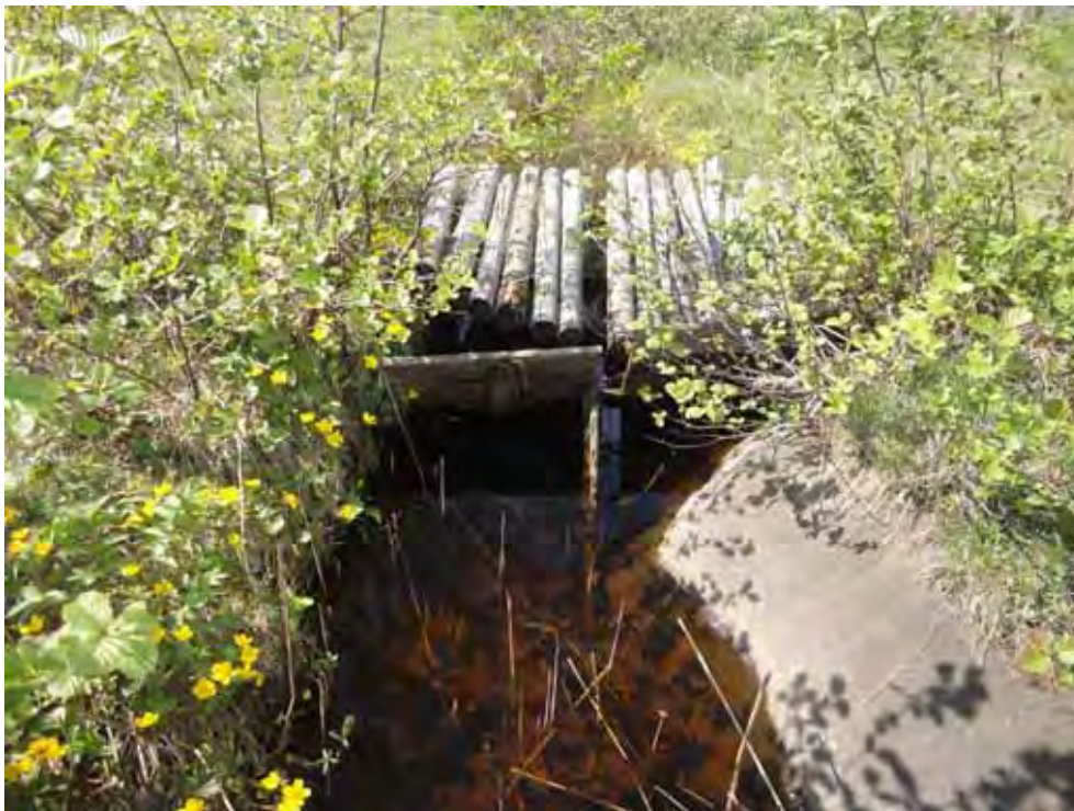
Figur 130. Gammal trädamm för reglering av vattenyta och flöde i utloppsåran vid Sebbersvik.
