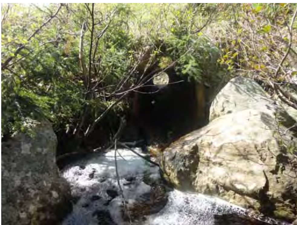
Figur 107. Vågtrumma i Långsjöbäcken som utgör ett vandringshinder och bör ersättas med en valvbåge.
