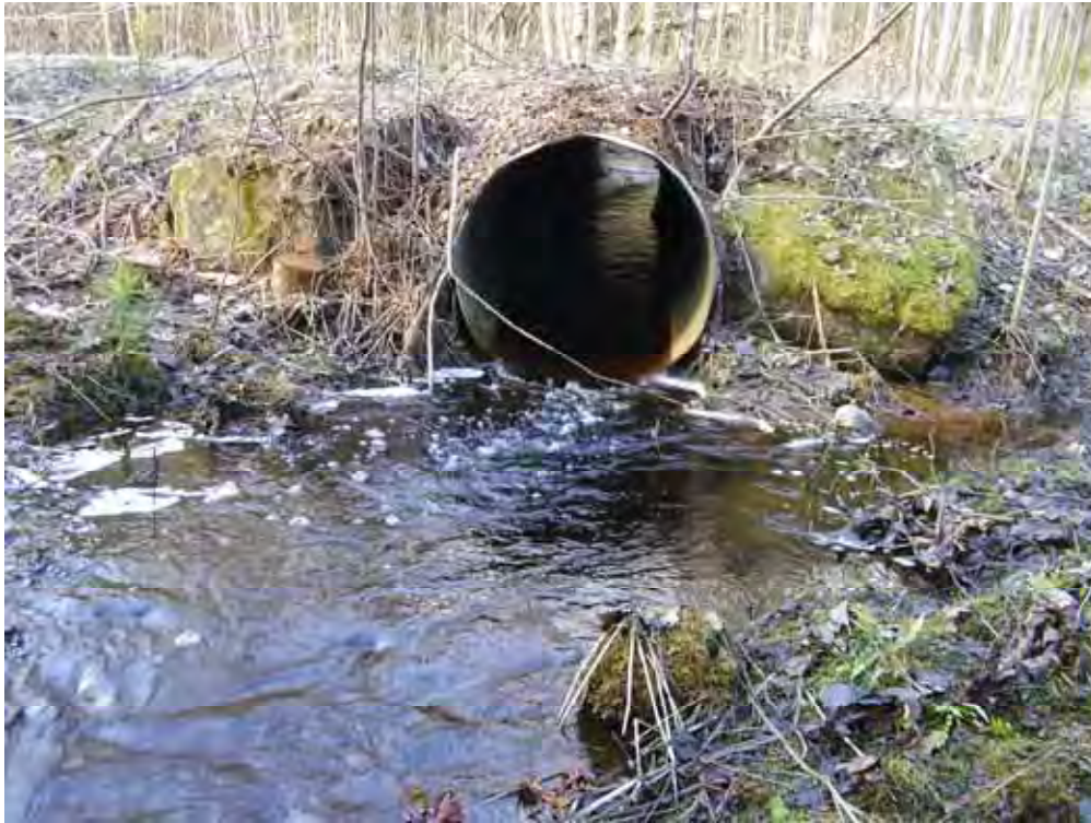
Figur 67. Vägtrumma som bedöms utgöra ett partiellt vandringshinder i bäckfåran mellan Fisksjön och havet.
