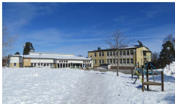
Iggesunds skola F-9. Ombyggnation startar 2020.
