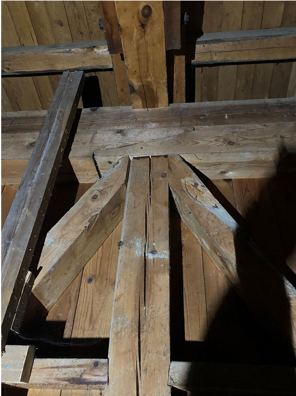
Hammarband av timmer samt anslutning takstol/hammarband/pelare.
