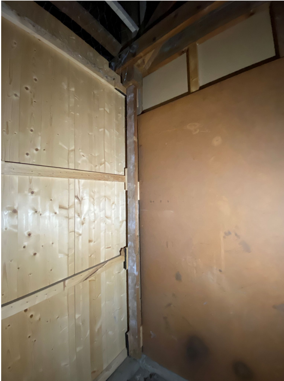
Bild tagen mot inredd kontorsdel, vissa ingrepp har gjorts i bärande konstruktion. Vidare utredning.
