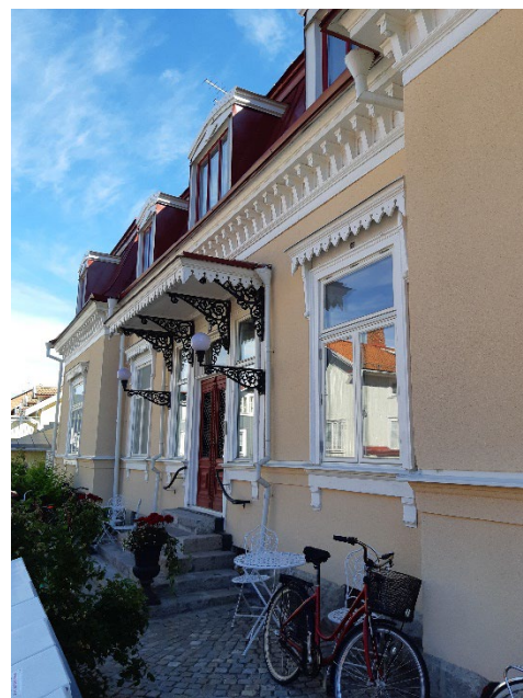
Bild 20: Bilden visar hur Borgmästarvillans takfot möter fasad med stor detaljrikedom, fönstrens omfattningar med vackra överstycken samt entrépartiets genomarbetade utformning. Fasaden är uppdelad horisontellt med profilerat listverk, så kallad gesims (Emma Nordebo Snygg 2022).
