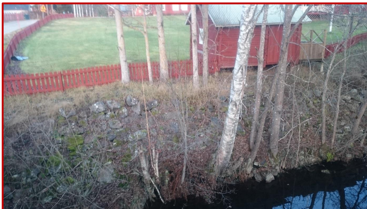
Figur 11. Delar av strandskoning längs norra stranden nedströms bron på Örängesvägen. Foto: Lena Berg Nilsson 2015.
