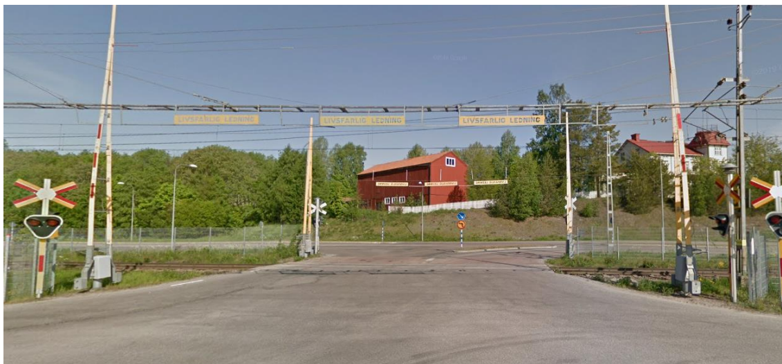
Bild 1. Plankorsning Timmervägen/Sågverksvägen och Stationsgatan.
