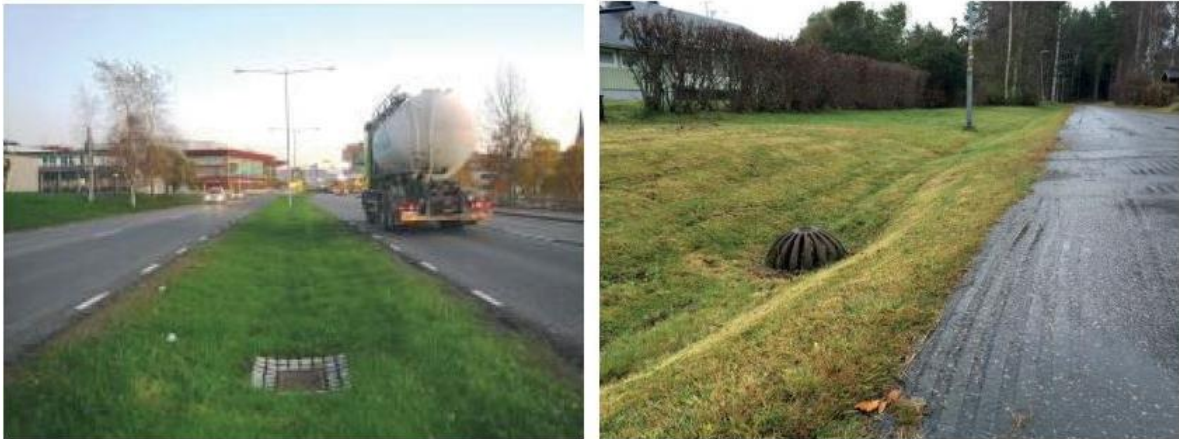
Figur 10. Två exempel på svackdiken. (Svenskt Vatten Utveckling, 2016)
