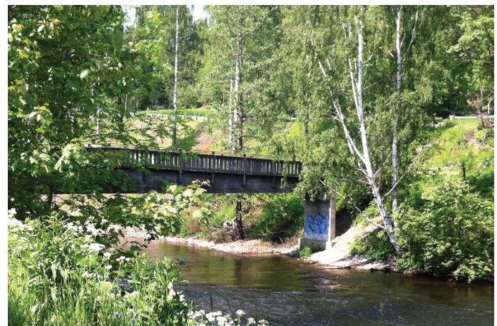
Foto 14: Bron över Iggesundsån.
