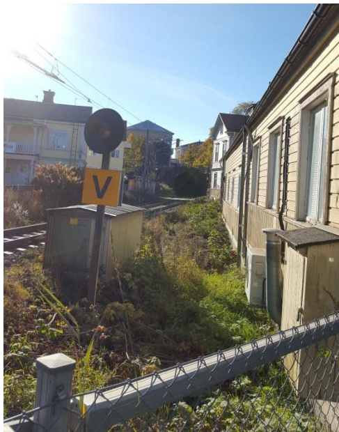
Figur 9. Yta mellan Ostkustbana och befintliga hus norr om tunneln.
