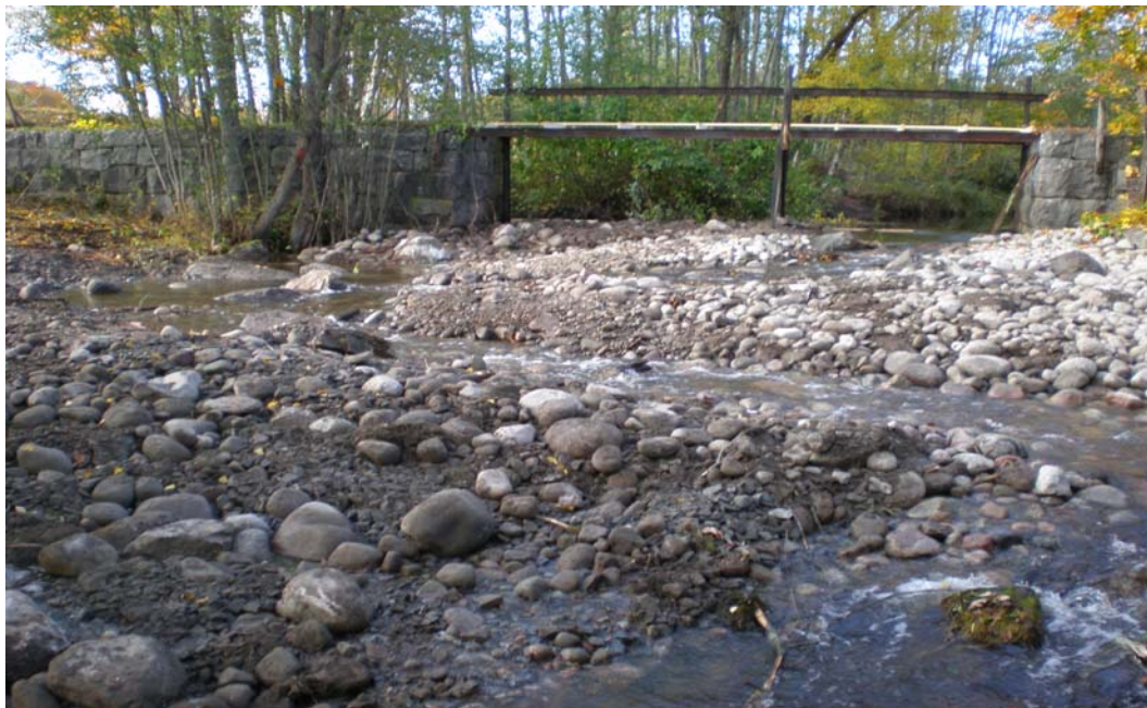
Figur 6. Vandringshinder i Enångersån som åtgärdats genom höjning av botten nedanför hindret. Fotot taget vid lågflöde.
