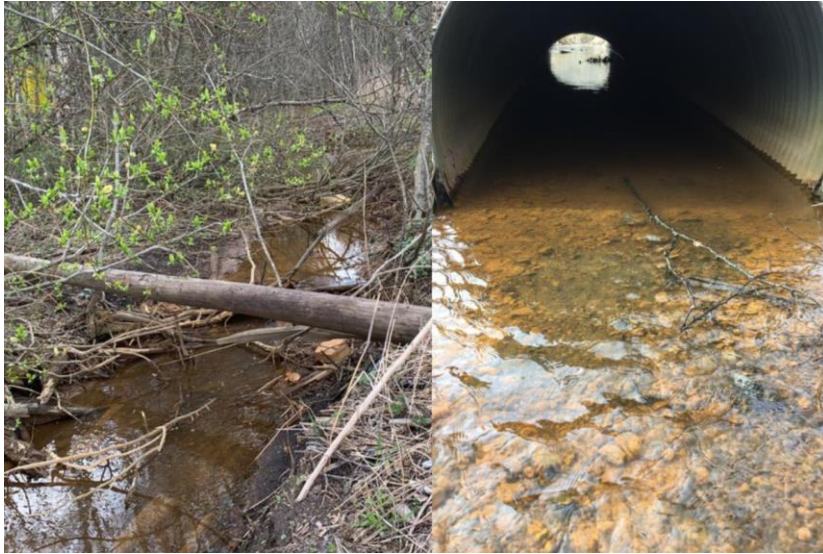
Figur 10. Bilder från vattendragets nedre del vid mynningen (vänster) och övre del vid kulverten under Timmervägen (höger). (Sweco, 2022)
