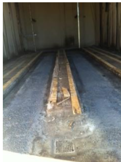
Figur 3. Inifrån befintlig tork
