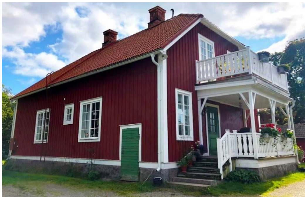
Bild 1: Tjänstemannabostad ritad av Cyrillus Johansson, uppförda mellan åren 1915 - 1918 vid Höckensvägen, sydöst om planområdet
