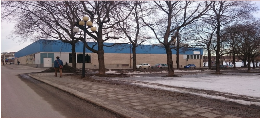
Vy mot befintlig byggnad och den fasad som vetter mot Marknadsgatan.
